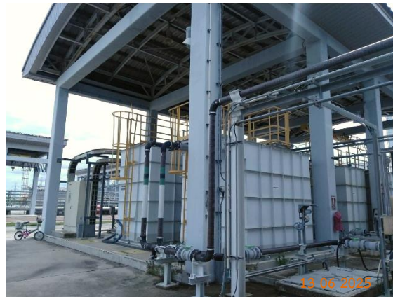
รูปที่ 2-12 ระบบบำบัดน้ำเสียแบบชีวภาพ ของสถานีรับ-จ่ายก๊าซธรรมชาติเหลว
