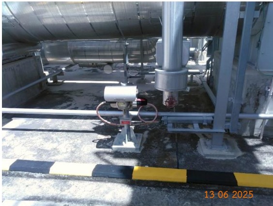
รูปที่ 2-22 ระบบตรวจจับไฟและก๊าซ
