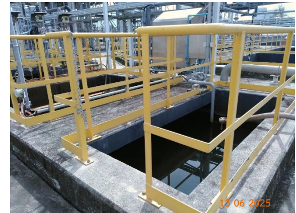
รูปที่ 2-13 ระบบแยกน้ำมันของสถานีรับ-จ่าย ก๊าซธรรมชาติเหลว
