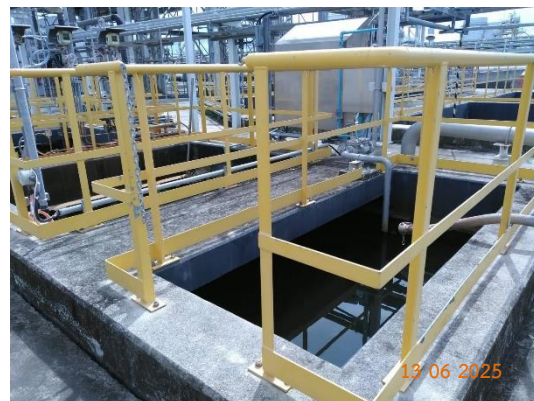
รูปที่ 1-7 ระบบ CPI Separator
