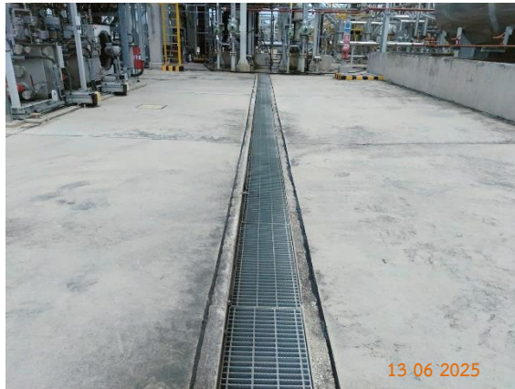
รูปที่ 2-14 รางระบายน้ำฝนภายในพื้นที่โครงการ
