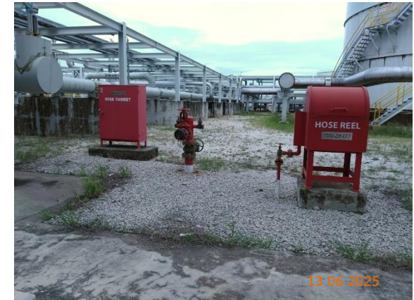
รูปที่ 2-24 หัวจ่ายน้ำดับเพลิงและตู้ดับเพลิงพร้อมสายน้ำ
